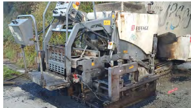
Travaux sous le tunnel de la Brière
